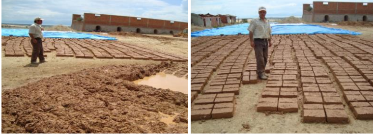
Görsel 2: Kerpiç, harcın karıştırıldığı yere yakın olarak dökülür.
