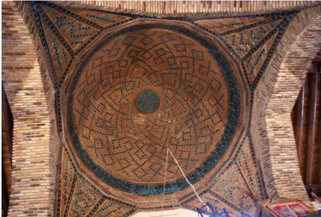
Şekil 6: Eşrefoğlu Camii mihrap önü kubbesi
