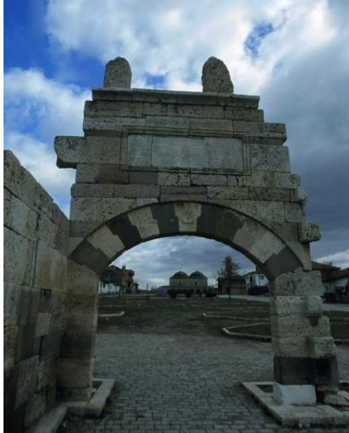
Fotoğraf 2: Beyşehir Surlarından Kale Kapısı ve Kitabeler
