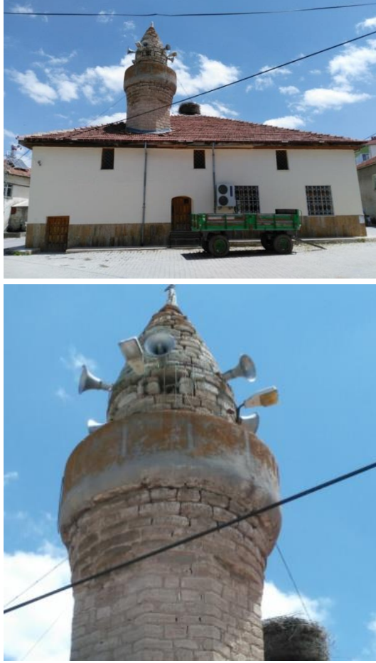
Görsel 28-29: Bayındır Köyü Camii batı girişi (üstte), minare (altta) (Uslu Bülbül, 2017)
