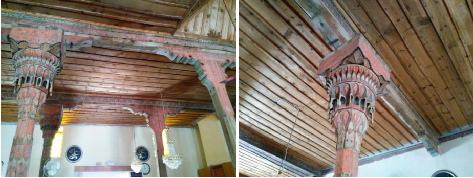
Görsel 32-33: Batıdaki ikinci ahşap sütun (solda), sütun detayı (sağda) (Uslu Bülbül, 2017)
