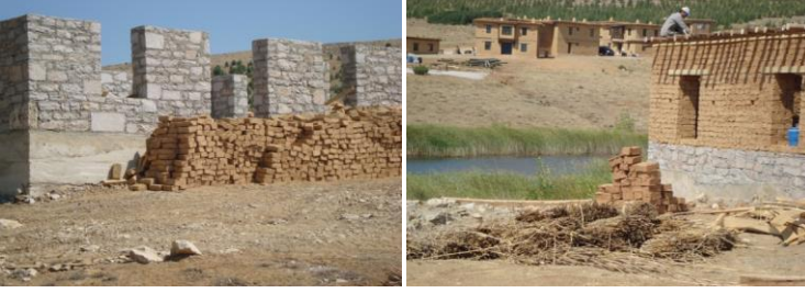
Görsel 7: Zemin kat veya subasmana kadar taş duvarlı, birinci kat ise kerpiç malzemeden yapılmakta.
