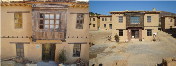
Görsel 23: Çıkımlarda ahşap malzemeler, duvarlarında kerpiç kullanılmıştır.
