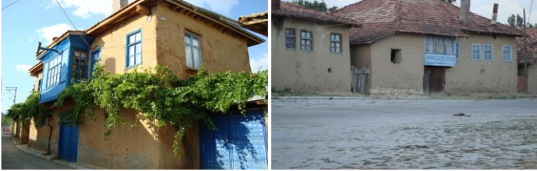
Görsel 19: Kerpiç evlerde çatı örtüsü olarak kiremit kullanılmıştır.
