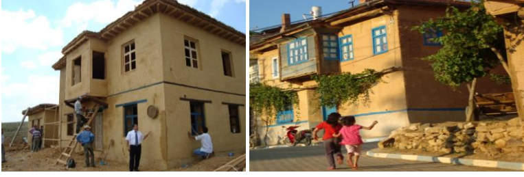
Görsel 9: Günümüz konut yapılarında kerpiç malzemeler kullanılmakta.
