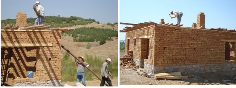
Görsel 10: Kerpiç konutlarda yöresel ahşap tavan kirişlemeler döşenmekte.
