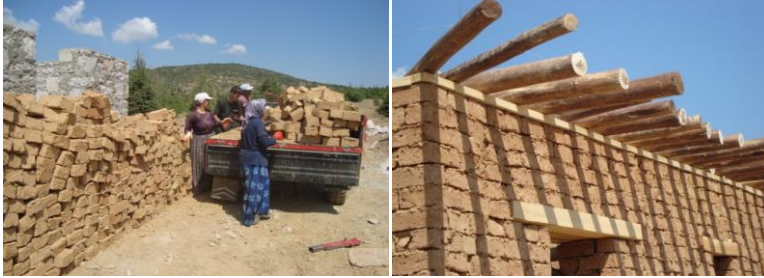
Görsel 11: Kurutulan kerpiçler ve ahşap kirişlemeler.
