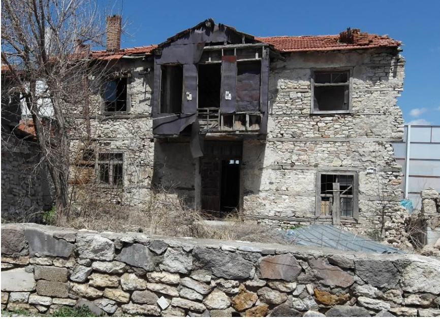
Görsel 12: Güney cephe görünüm
