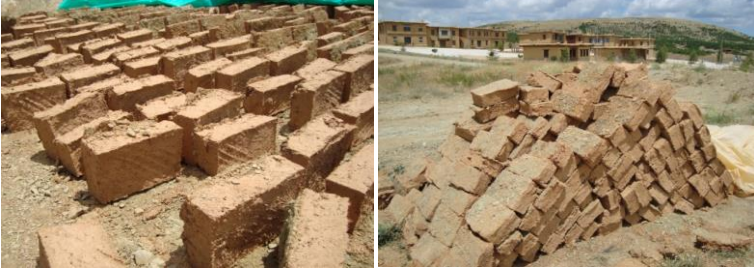
Görsel 4: Kerpiç kuruması için çevrilir ve kuruyanlarda yığın halinde dizilir.
