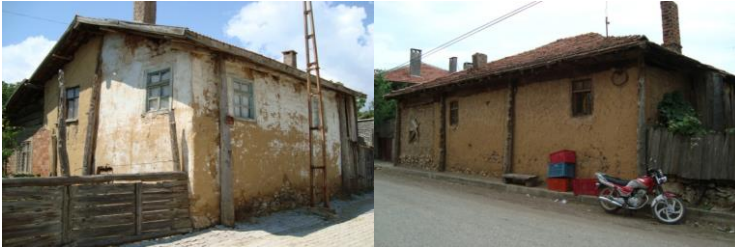
Görsel 17: Zemin katlarda genellikle depo veya ahır düşünülendiğinden pencere açılmamıştır.
