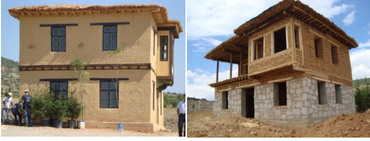
Görsel 27: Zemin katta taş, birinci katta kerpiç kullanılmıştır.
