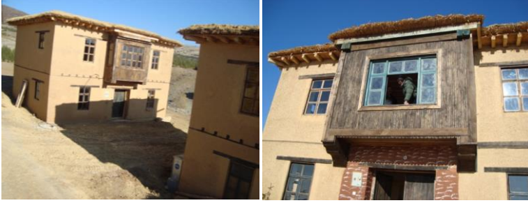
Görsel 24: Bina giriş kapısı üzerine çıkma yapılmıştır.
